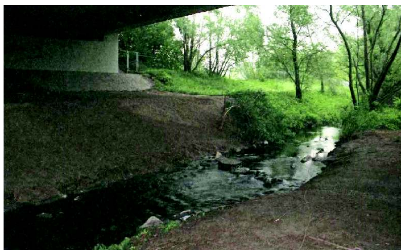
Fot. 6. Przykład naturalnie ukształtowanych skarp otwartego koryta rzecznej Silnicy biegnącego pod układem drogowym (za: Poradnik projektowania przejść dla zwierząt(...), R.T. Kurek)
